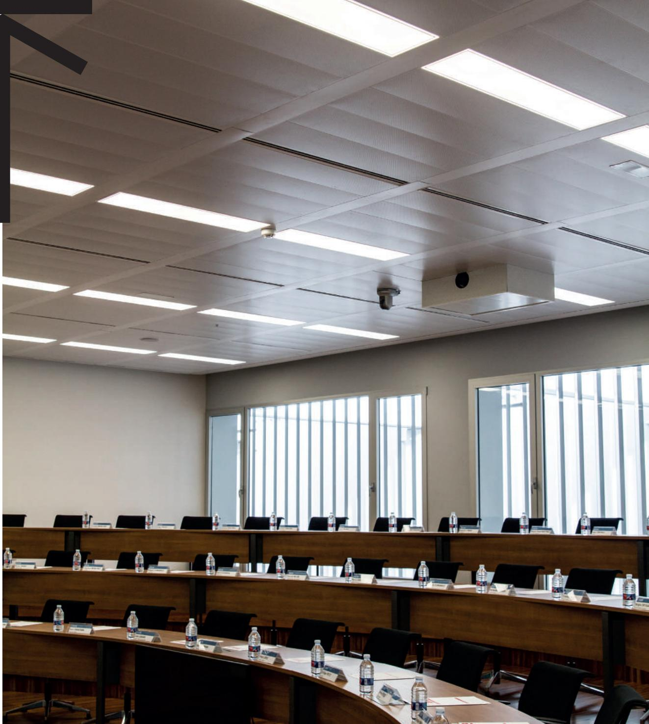
La Lama Turín es un Sistema de techo metálico de cantos rectos a 90° instalado mediante un perfil visto en forma de "U" de 100 mm. La placa apoya y engarza sobre éste quedando todo el sistema enrasado al mismo nivel. Los carriles perpendiculares que forman los perfiles respecto de las bandejas, otorgan al techo una estética elegante y funcional.
