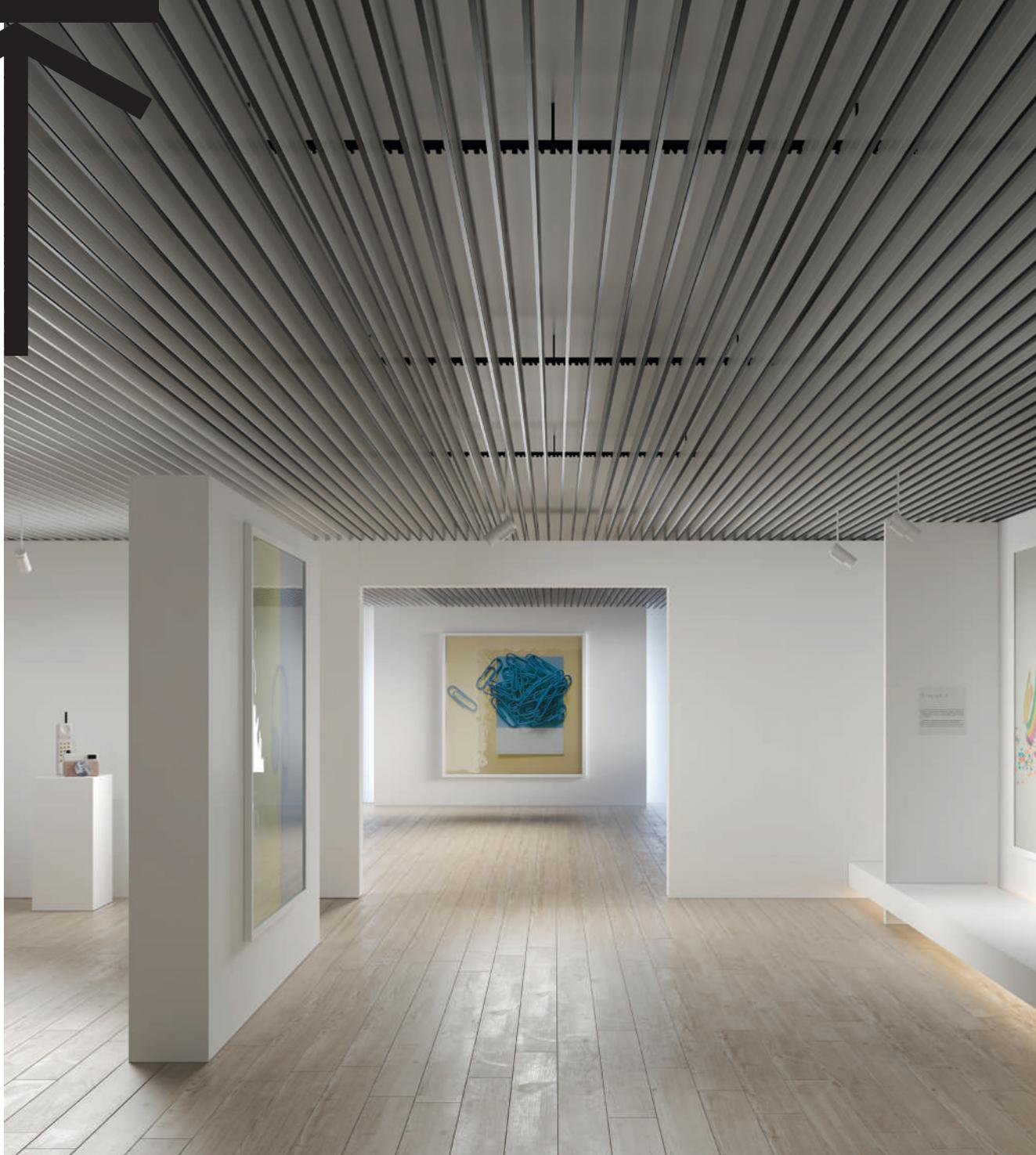
Este tipo de techo de lamas verticales permite jugar con la **luminosidad de espacios diáfanos y abiertos**. Mediante un sistema de rastreles lacados en negro, se construye una estructura de lamas verticales de 100, 150 o 200 mm. Según el tamaño de la lama, éstas pueden colocarse a diferentes distancias en el rastrel permitiendo **multitud de combinaciones**.
