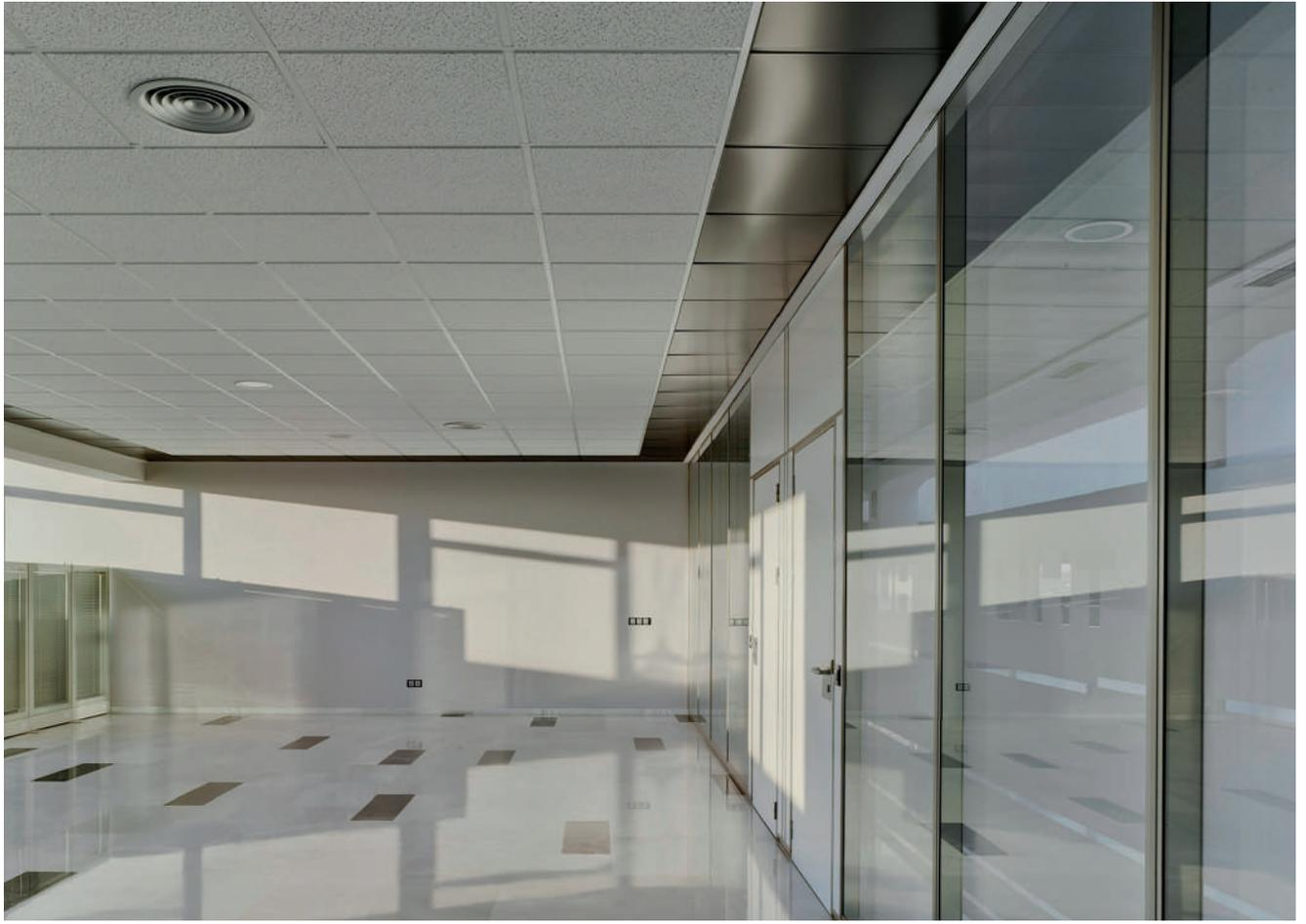
Los techos de fibra Mineral de OWA son fabricados en Alemania, y representan la más alta calidad y rendimiento en conexión con el alto aislamiento acústico, reducción del nivel de ruido y seguridad contra incendios.
