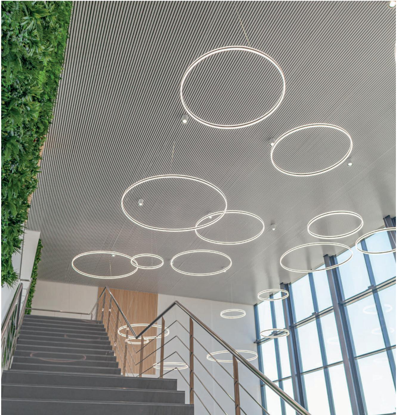
Este tipo de techo de cielo abierto está formado por un sistema de rastreles lacados en negro a modo de estructura donde se alojan las **laminas rectangulares** de 30 mm de ancho. Las laminas son fabricadas en aluminio prelacado de gran **resistencia y durabilidad**, y al tratarse de un techo de cielo abierto se garantiza un **fácil mantenimiento** y acceso al plenum.
