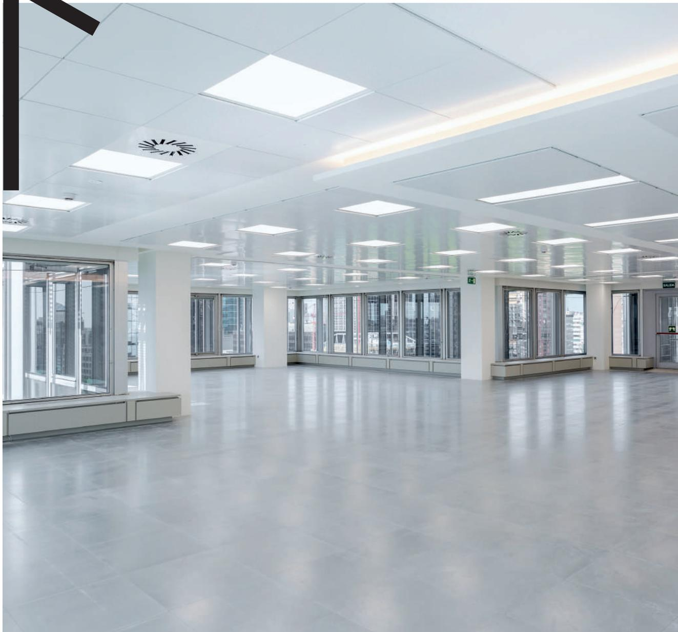
Techo técnico modelo panel Florencia de THU formado por paneles fabricados en acero prelacado o postpintado. Se trata de placas de canto recto con sistema de perfilera semiculta T24 mm y modulación variable en función del proyecto.
