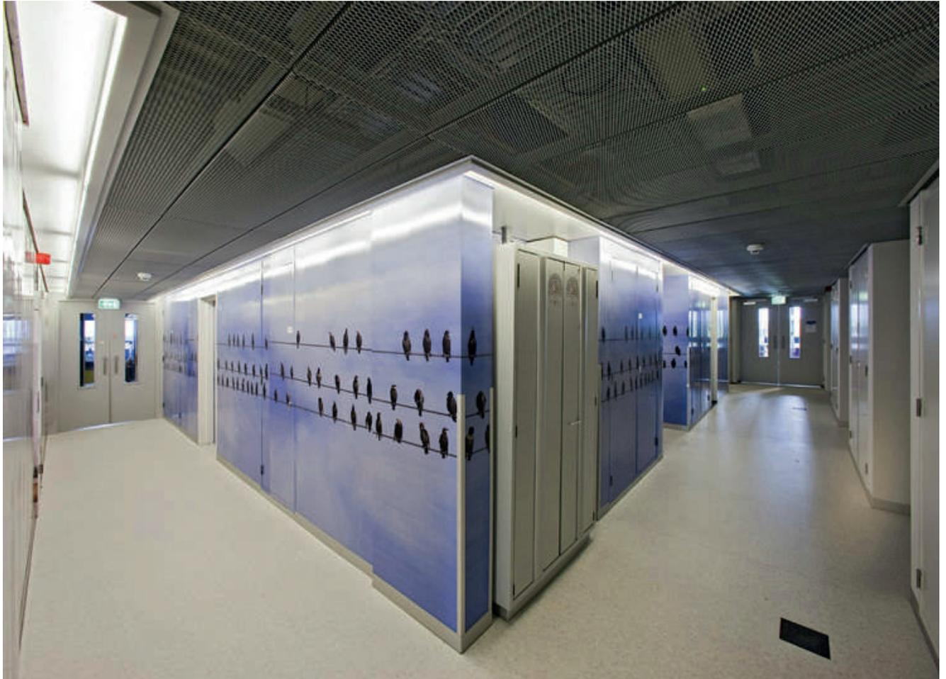
Los falsos techos de metal expandido, también conocidos como deployée, están fabricados a partir de bobinas de acero o de aluminio precortadas en diferentes dimensiones de rombo o trama interior.
