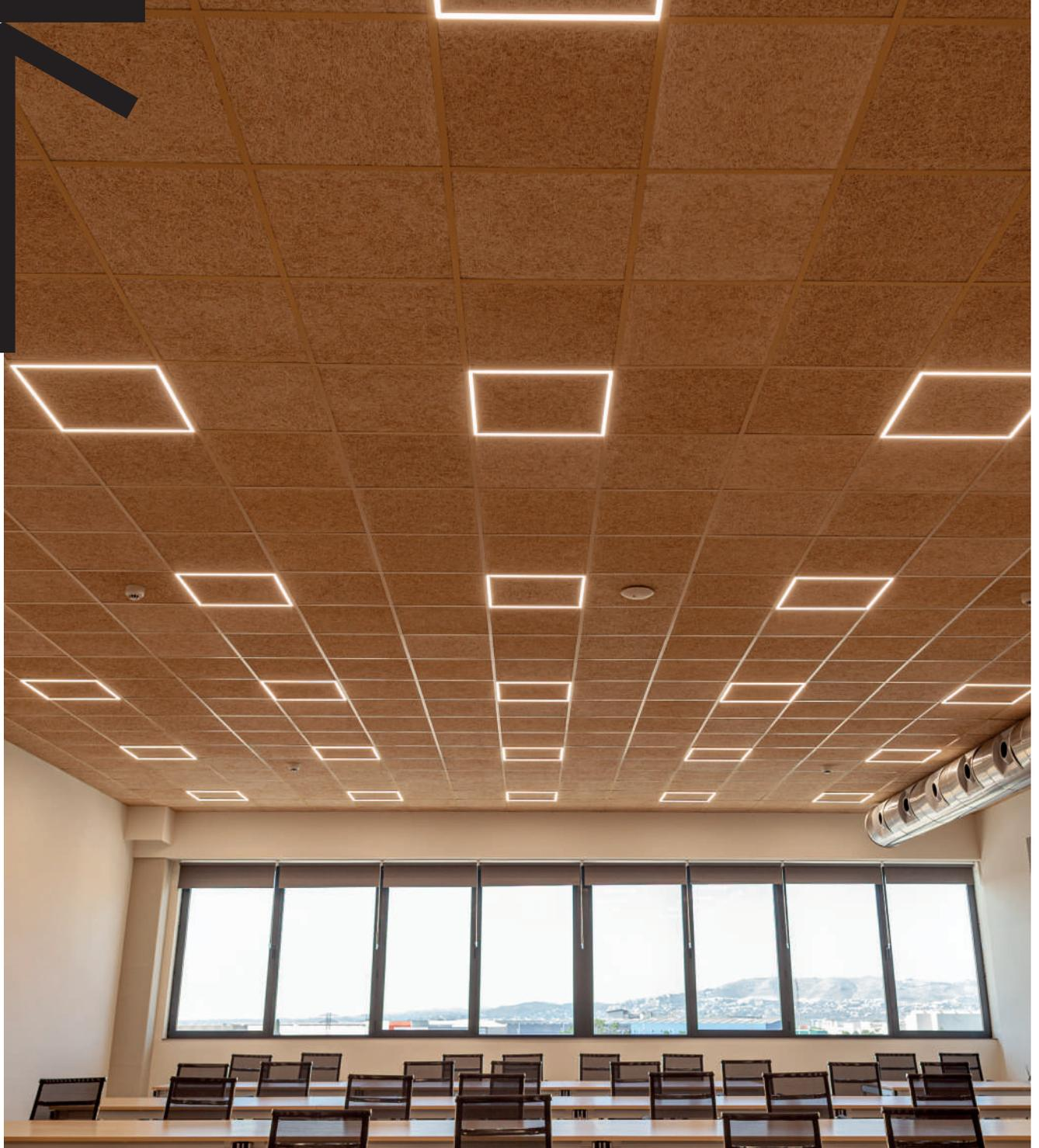
Los paneles de viruta de madera para techos y paredes están fabricados por fibras vegetales de bosques sostenibles. Las fibras alargadas de abeto se mezclan con cemento, obteniendo un material rígido que se caracteriza por un comportamiento acústico sobresaliente. Los techos de este material aportan calidez y estética. Este **producto 100% natural** es conocido por sus excelentes cualidades de absorción sonora, creando una excelente acústica en todos los espacios.
