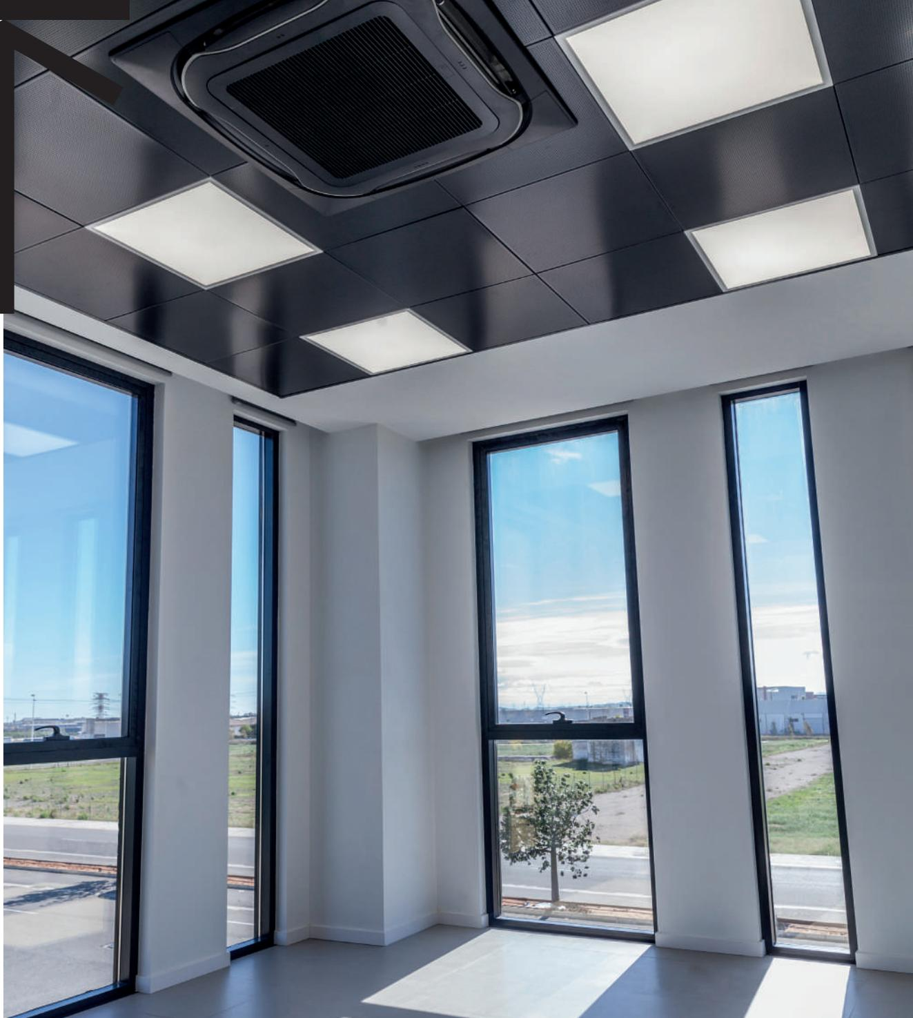
El modelo de techo Sicilia Clip-In ofrece un espacio continuo gracias al sistema de perfilería oculta THU. Los principales formatos se dividen en retículas de 600 x 600 mm, 600 x 1200 mm y 300 x 1200 mm, posibilitando la adaptación en ambientes diferentes. **La facilidad de registro del techo permite el acceso a todo tipo de instalaciones.**
