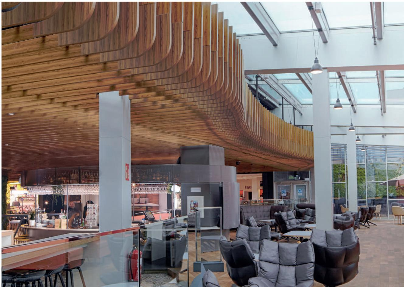
El Baffle Acústico aporta una **estética actual** y **mejora el confort acústico** de las superficies donde se instale. Se trata de un falso techo metálico formado por baffles de anchos y alturas variables de acuerdo con las especificaciones del proyecto.
