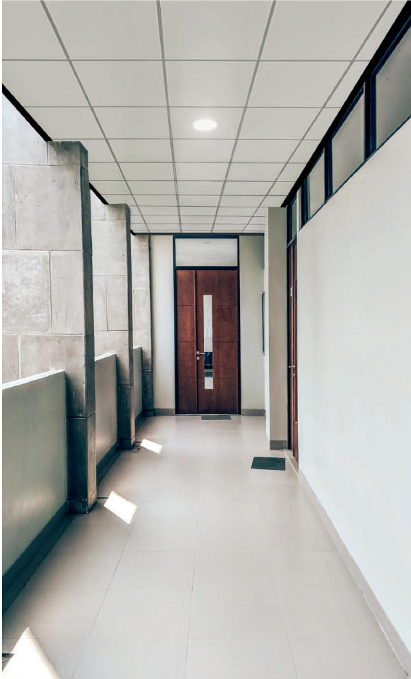
El sistema PARMA T15 ofrece una **estructura registrable** de techo metálico en formatos 600x600 mm y 300x1200 mm apoyada sobre perfiles T 15, T-Clip 15 y T-Decor 15. Si añadimos los acabados de bandeja enrasada, tegular de canto biselado (V6) y canto recto (V8), conforman una **gran cantidad de combinaciones** para la decoración de espacios.
