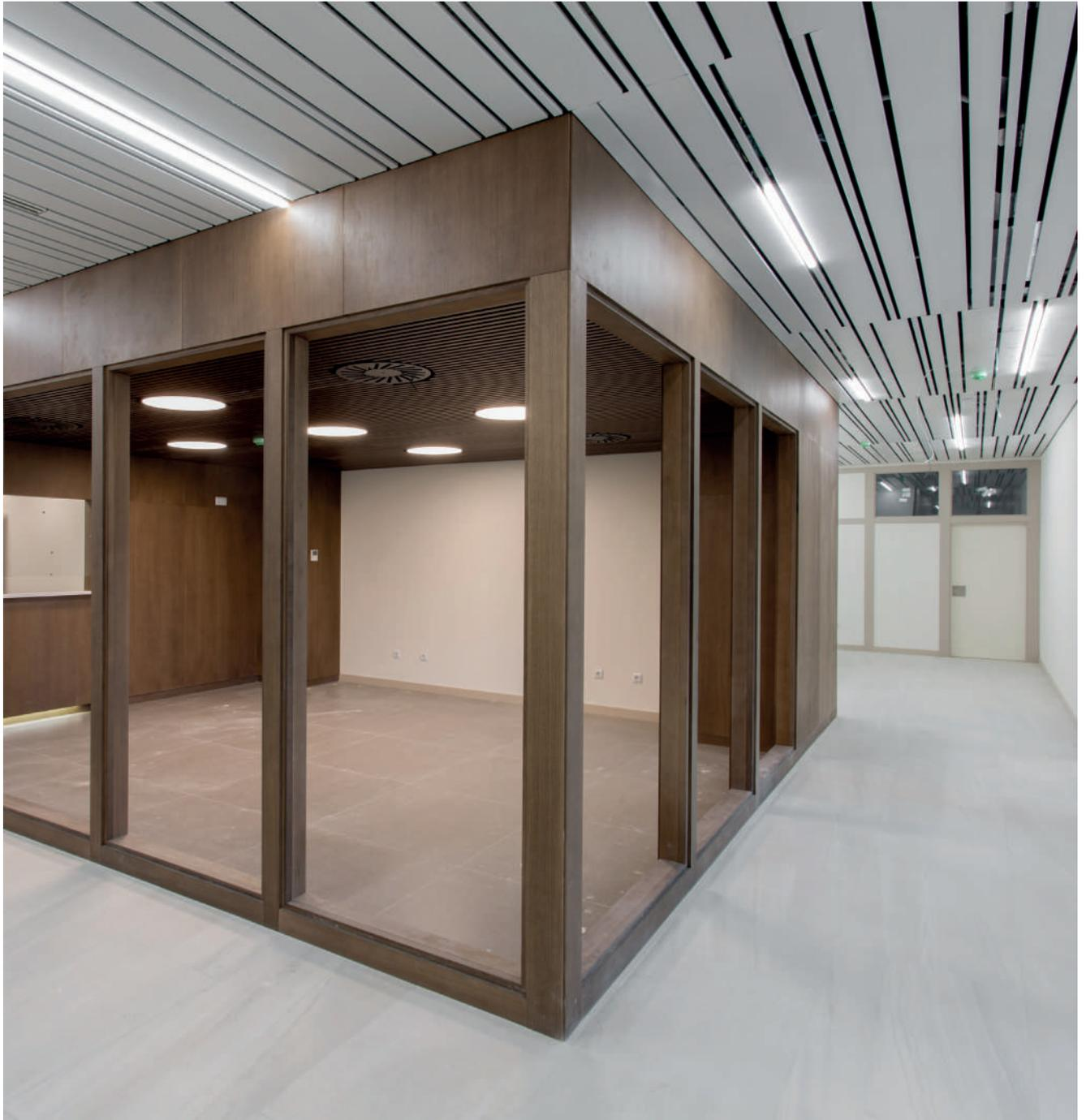
Falso techo lineal formado por lamas fabricadas en aluminio combinables en el mismo soporte de sujeción de manera aleatoria de anchos disponibles de 30, 80, 130 y 180 mm.
