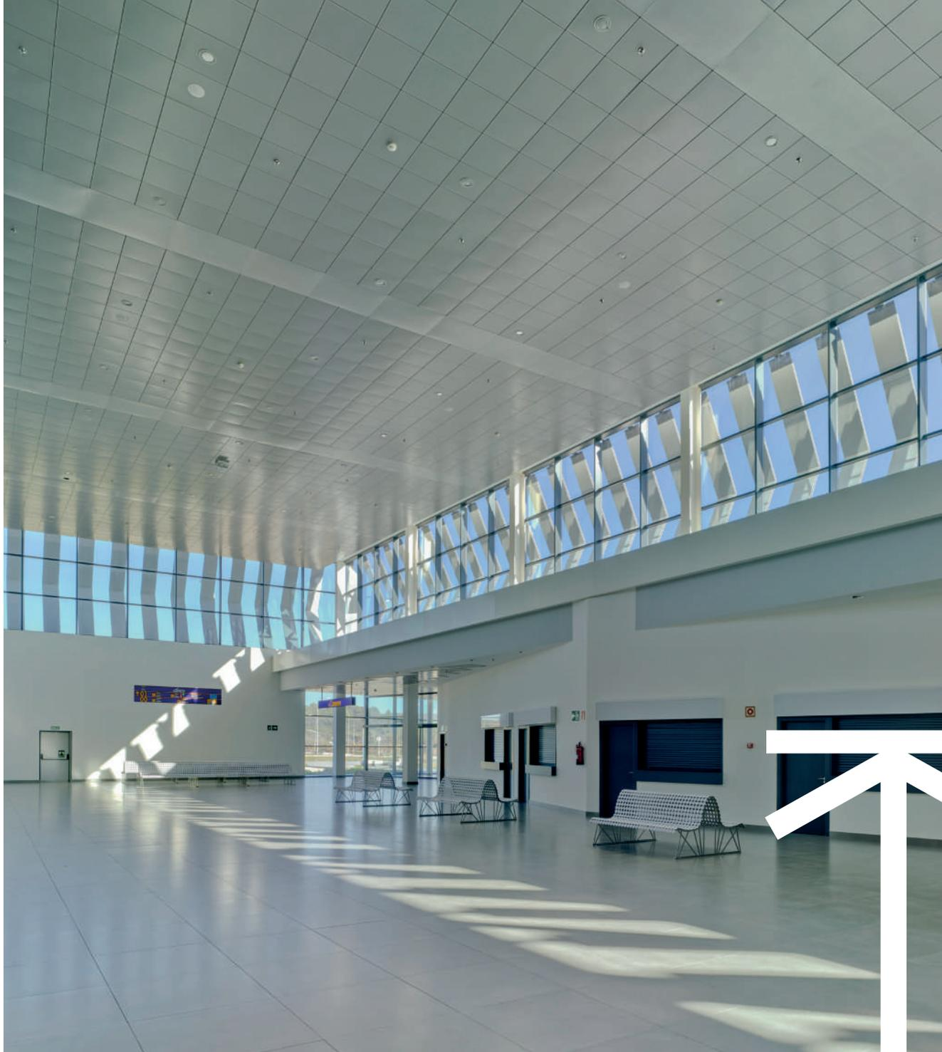
Bandejas fabricadas en acero galvanizado prelacado cuyo espesor le confieren una gran resistencia y durabilidad. Debido a su formato de 1000x1000 mm, están especialmente diseñadas para su colocación en espacios de considerables dimensiones. Además, permiten acceder a las instalaciones técnicas situadas en el plenum de manera sencilla y cómoda, haciendo de él un techo totalmente registrable en toda su extensión.
